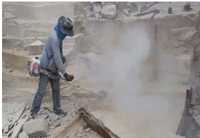
ก่อนตัดอุปกรณ์ลดฝุ่น (มีปริมาณฝุ่นมากและฟุ้งกระจาย)
